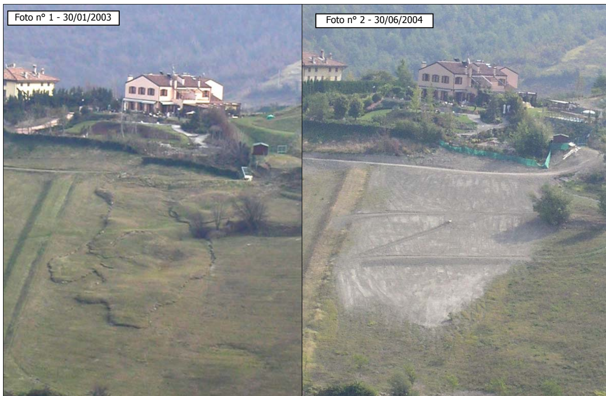
Panoramica area in frana nel Parco S.Pellegrino lungo il versante orientale del Rio Meloncello (prima e dopo la sistemazione)
