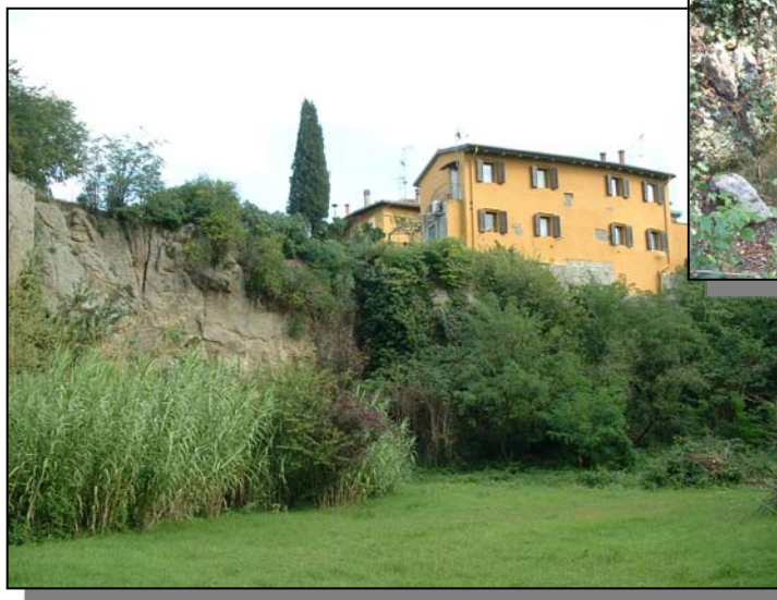
Foto 3.7 – Particolare scarpata di scavo
