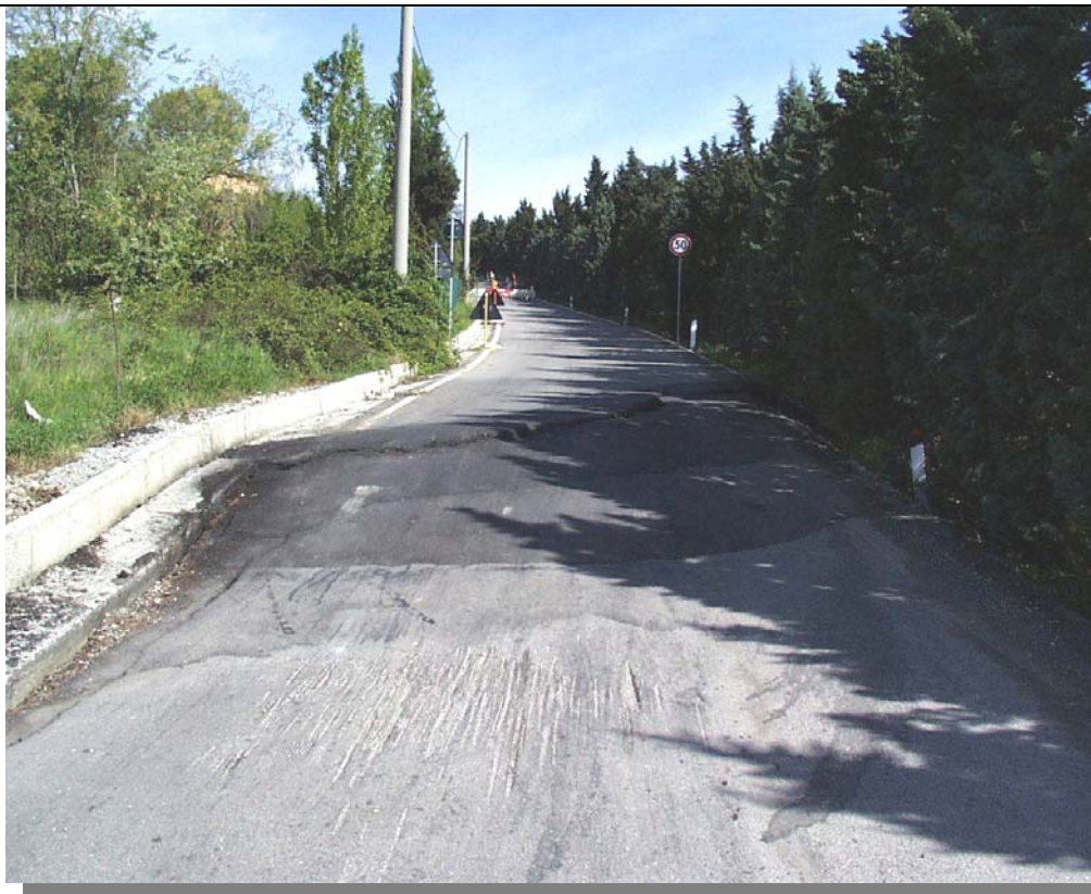
Foto 1 – Particolare dei dissesti del 2001
