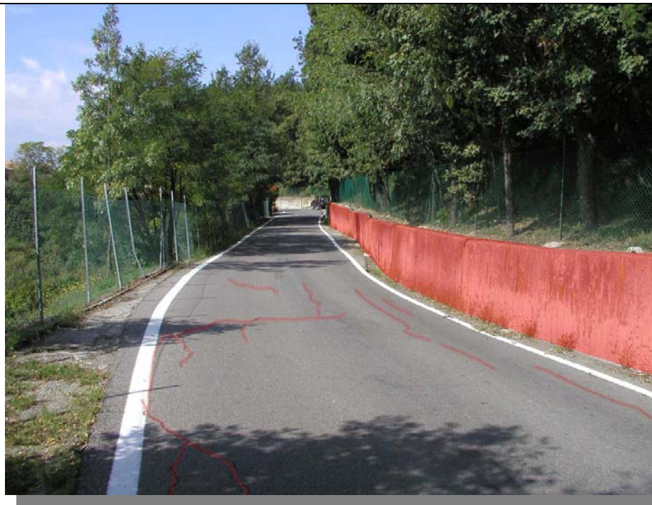
Foto 1 – Tratto di strada visto da Ovest
