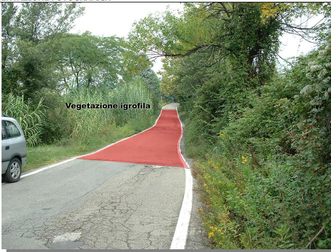
Foto 1 – Tratto di strada dissestata
