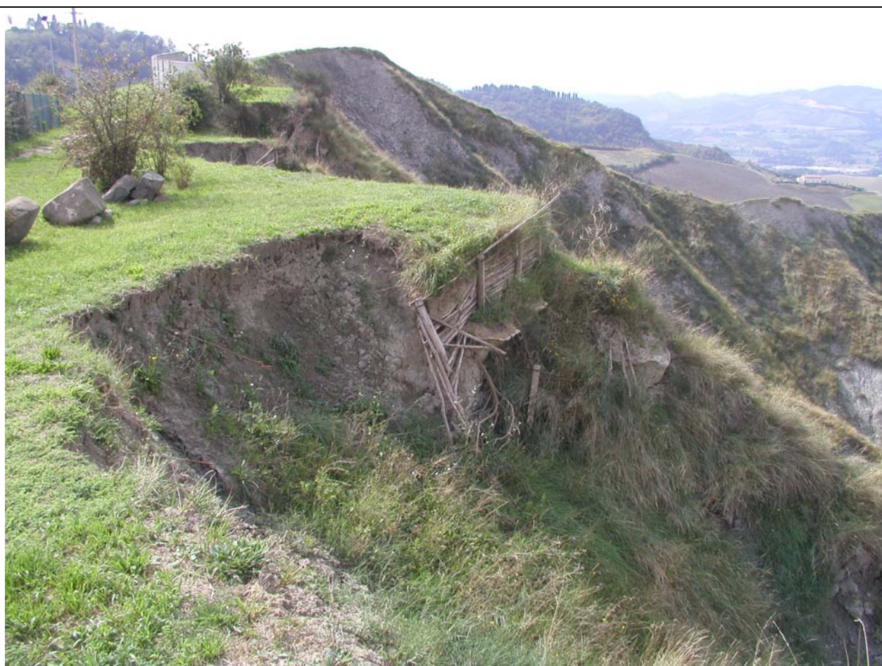
Foto 3 – Particolari dissesti delle pendici del calanco
