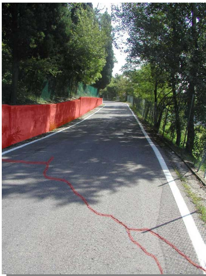
Foto 2 – Tratto di strada visto da Est
