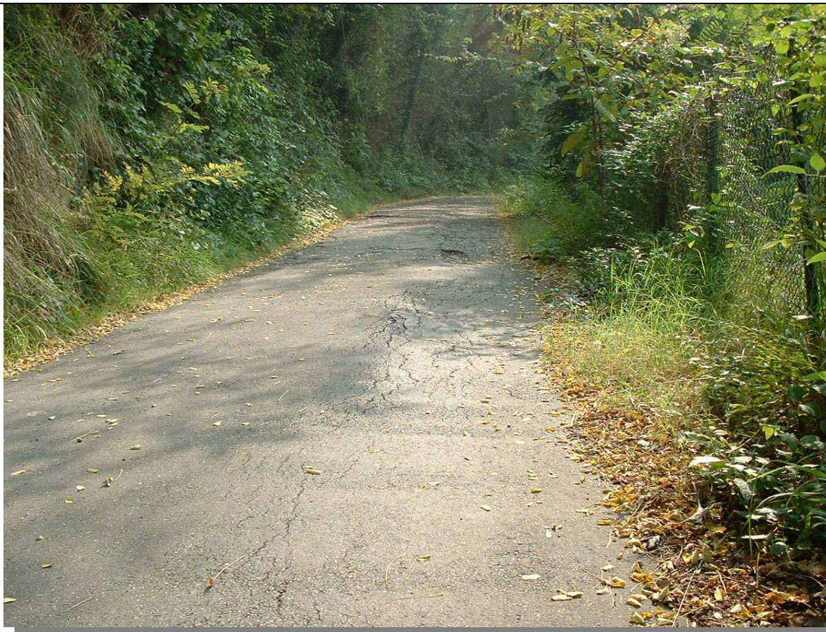
Foto 1 – Particolare dissesti della strada
