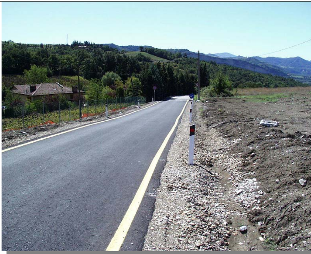
Foto 2 – Tratto stradale dopo la sistemazione
